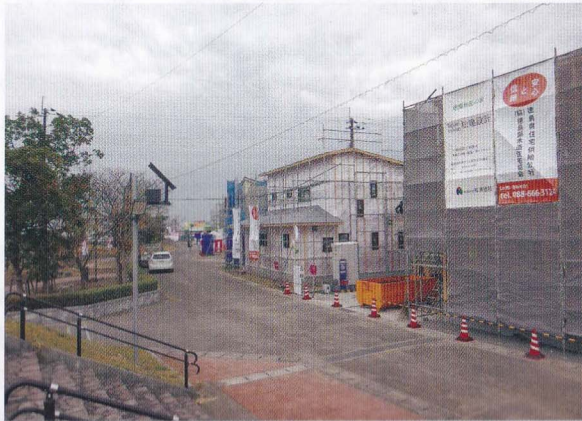
7社のモデルハウスが並んで建つ。長期優良・耐震等級3・制震ダンパー採用と構造的な性能を統一した
